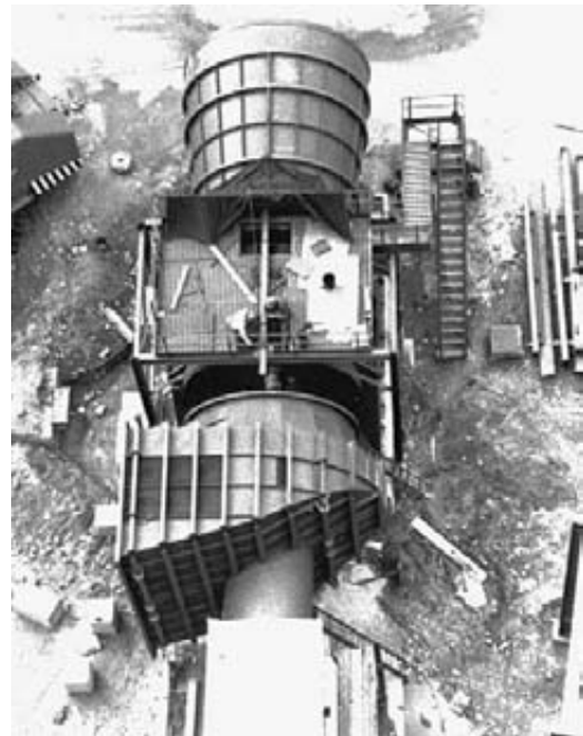
Figura 24.19 Este ventilador de tiro forzado proporciona 445 m 3 /s de aire con una diferencia de presión de 5.8 kPa para una planta de potencia térmica. Es propulsado por un motor de inducción trifásico de 12 000 hp (8955 kW), 60 Hz y 890 r/min. (Cortesía de Novenco Inc.)
