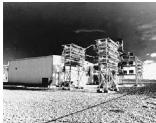
Figura 25.39 Compensador variable estático para una línea de alto voltaje. (Cortesía de General Electric)
