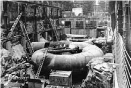
Figura 24.11 La caja espiral alimenta agua alrededor de la circunferencia de una turbina de 483 MW. (Cortesía de Marine Industrie)
