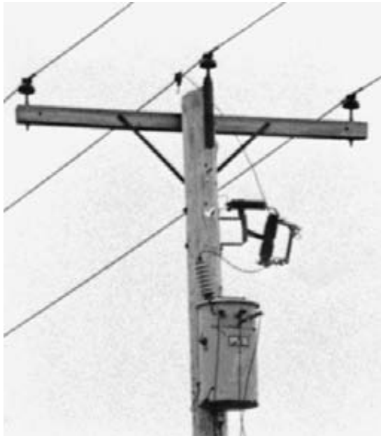
Figura 11.2 Transformador de distribución monofásico con capacidad de 100 kVA, 14.4 kV/240 V/120 V, 60 Hz, instalado en un poste.
