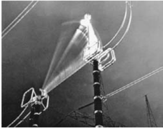
Figura 26.11 El arco producido entre los cuernos de un interruptor de desconexión en el momento en que interrumpe la corriente de excitación de un transformador de alto voltaje, proporcionó la luz para tomar esta foto nocturna. (Cortesía de Hydro-Québec)
