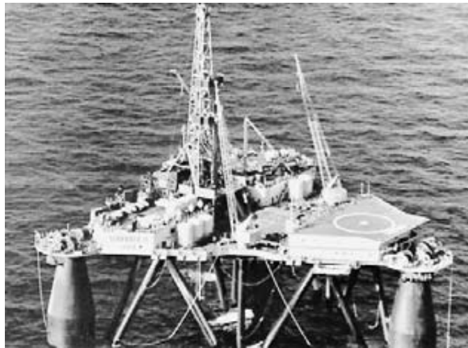
Figura 16.25 Esta plataforma petrolera flotante satisface sus propias necesidades de energía. Cuatro generadores de 1200 kVA, 440 V, 900 r/min y 60 Hz propulsados por motores diesel abastecen toda la energía eléctrica. Aunque se genera y distribuye potencia de ca, todos los motores a bordo son motores de cd controlados por tiristor. (Cortesía de Siemens)
