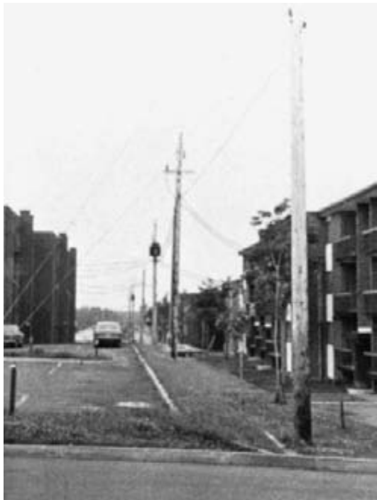
Figura 26.28 Alimentador aéreo de MV que da servicio a un distrito residencial.
