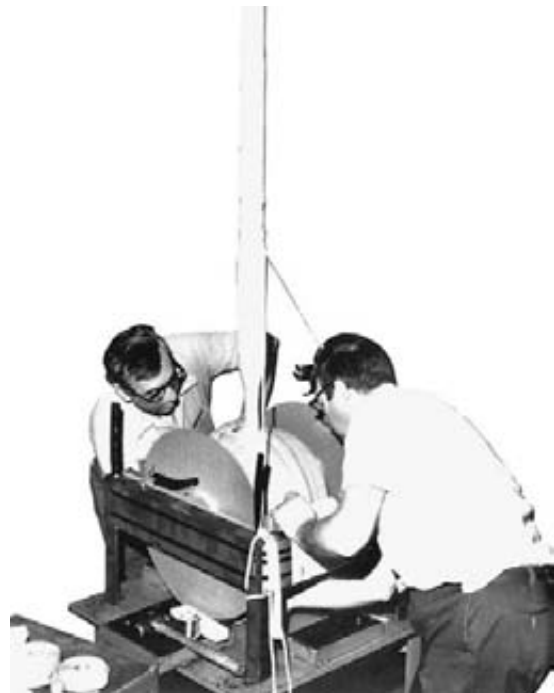
Figura 11.15 Transformador de corriente en el proceso final de construcción. (Cortesía de Ferranti-Packard)
